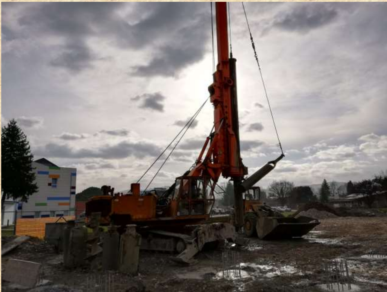
Alcuni dei 50 pali di fondazione. Sulla sinistra La Casa della Salute
