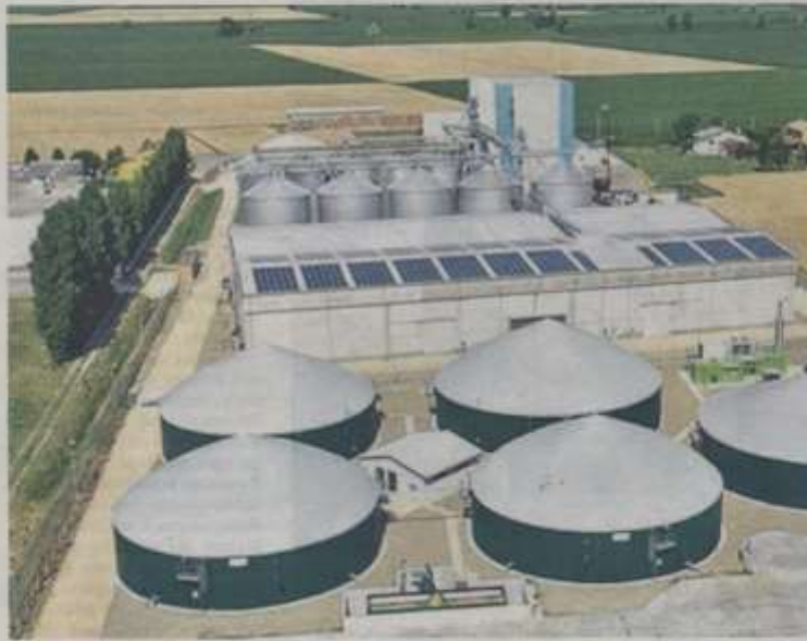
Un tipico impianto di biodigestore anaerobico realizzato negli ultimi dieci anni in varie parti d'Italia.
