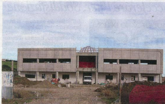
VIA PIAN MAURO Il cantiere della nuova sede dell'Unione
