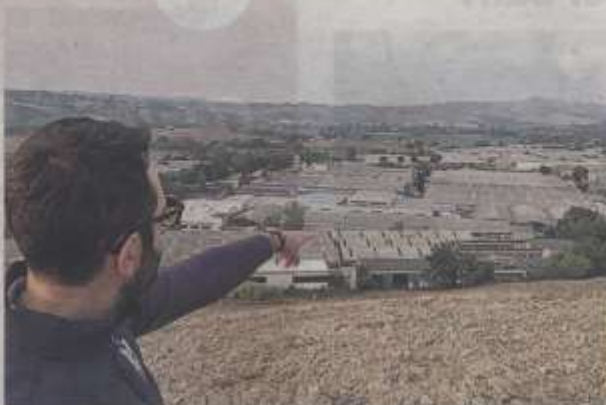
Andrea Ricci indica la distesa di capannoni dai tetti rivestiti in eternit a Talacchio
