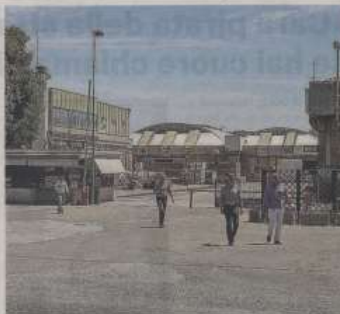
Ingresso dell'ex stabilimento Pica lungo la strada statale Urbinate
