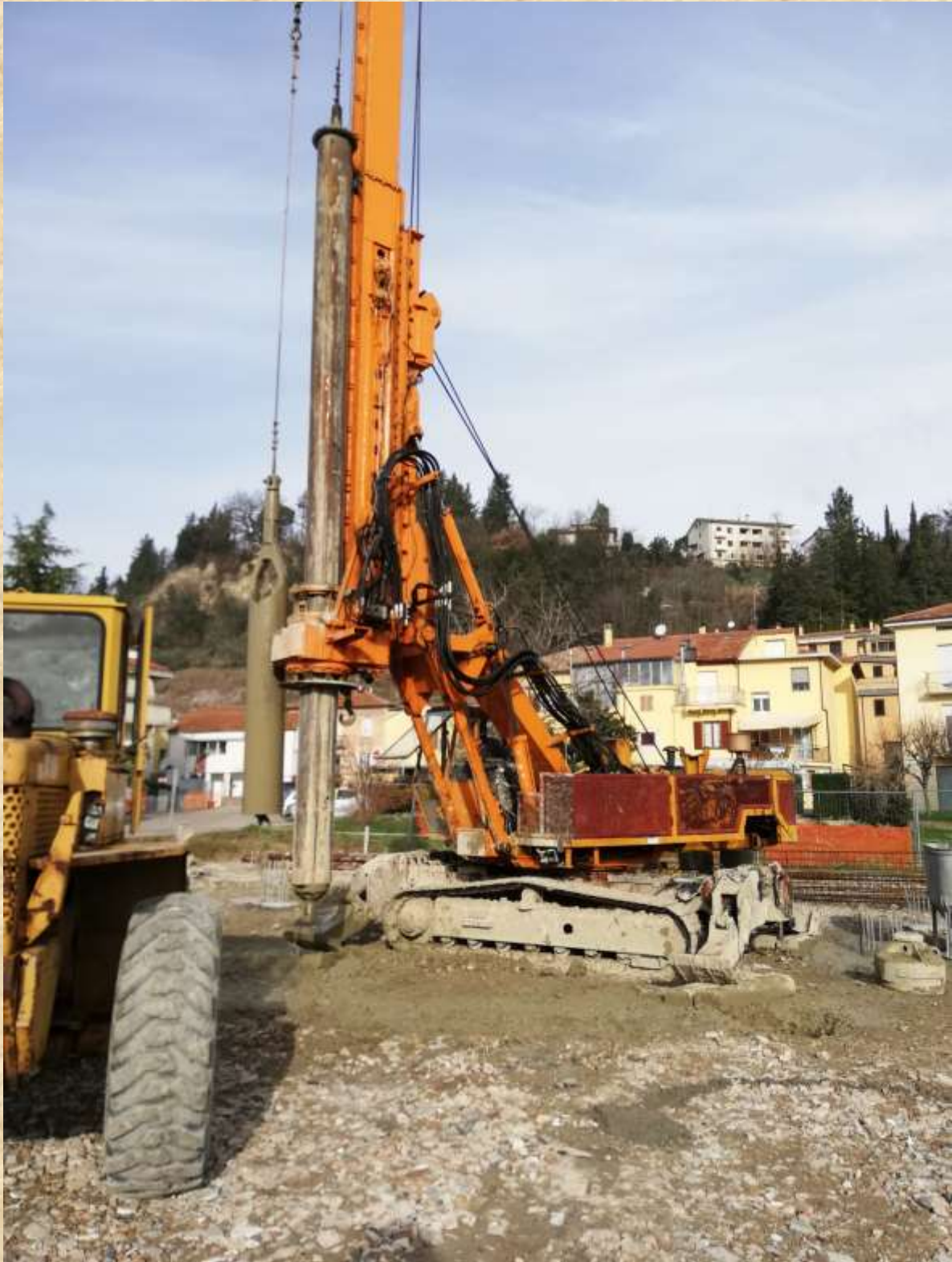
Il cantiere con le macchine in fase di perforazione
