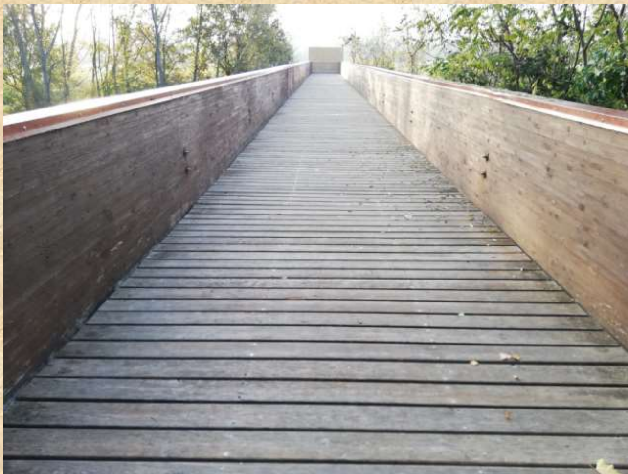
Ponte in legno sulla pista ciclopedonale Bottega-Pian del Bruscolo
