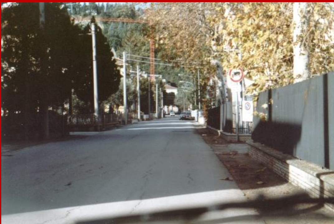
2005 Via 25 Aprile sulla destra dove sorgeva la fabbrica Bruscoli oggi si trova una nuova lottizzazione residenziale
