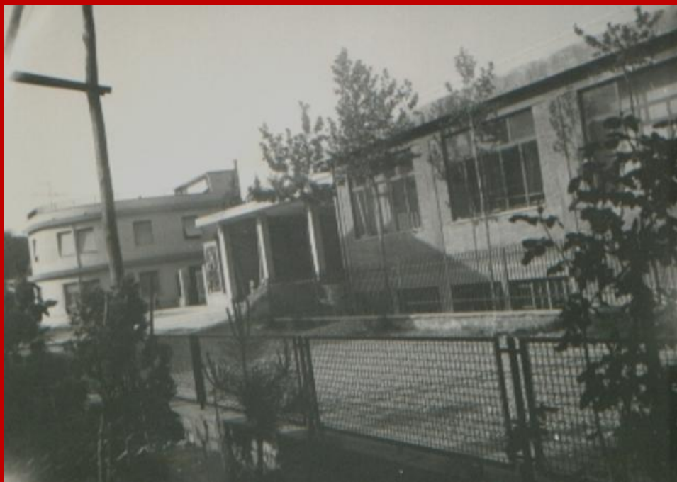
1969 La fabbrica di mobili Bruscoli lungo Via 25 Aprile
