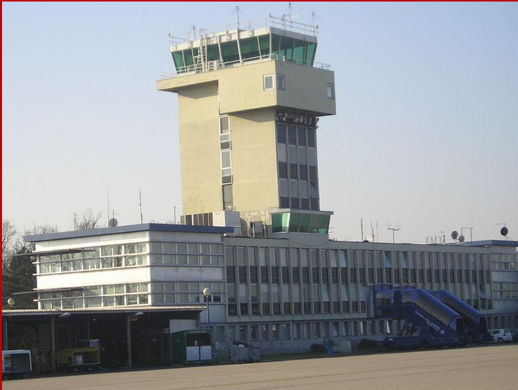
Torre di controllo aeroporto di Zagabria.
