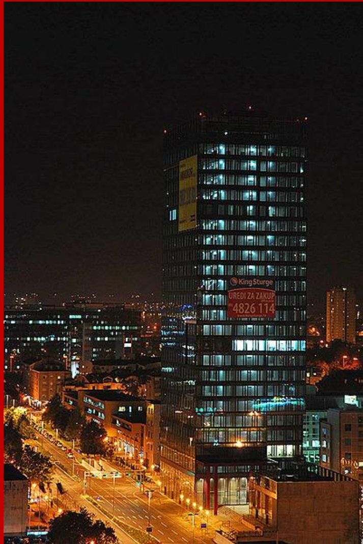
Eurotower, sede della Zagreb Stock Exchange
